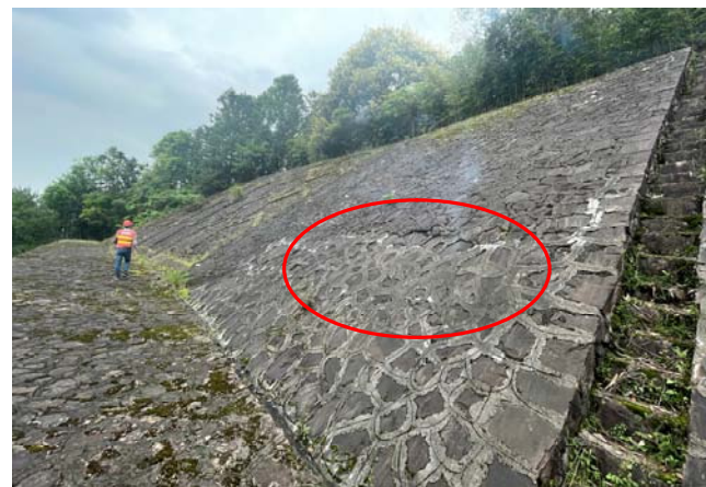
图 8 护面墙裂缝
